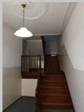
Requalificação da entrada (área de acolhimento dos utentes) da sede da Cáritas Diocesana do Funchal
