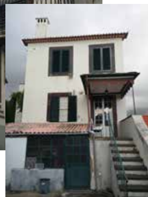
Fotografia da fachada sul.
